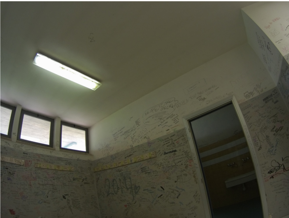
Attuale situazione degli spogliatoi degli studenti
