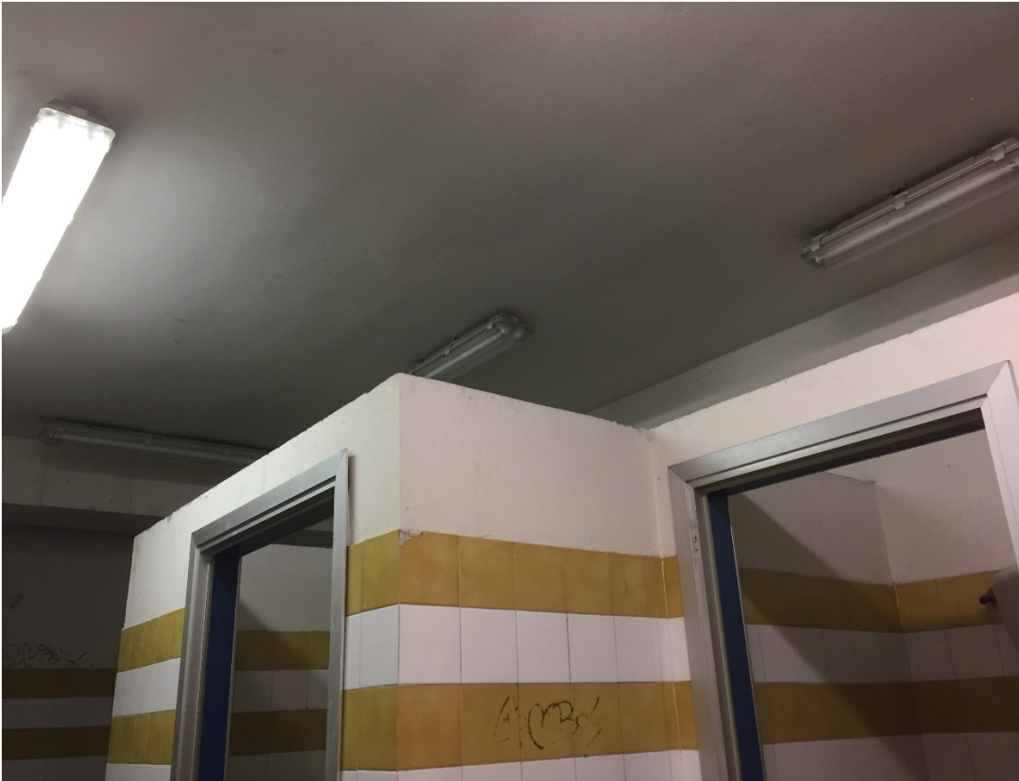
Particolari rivestimenti dei bagni spogliatoi studenti e assenza delle porte
