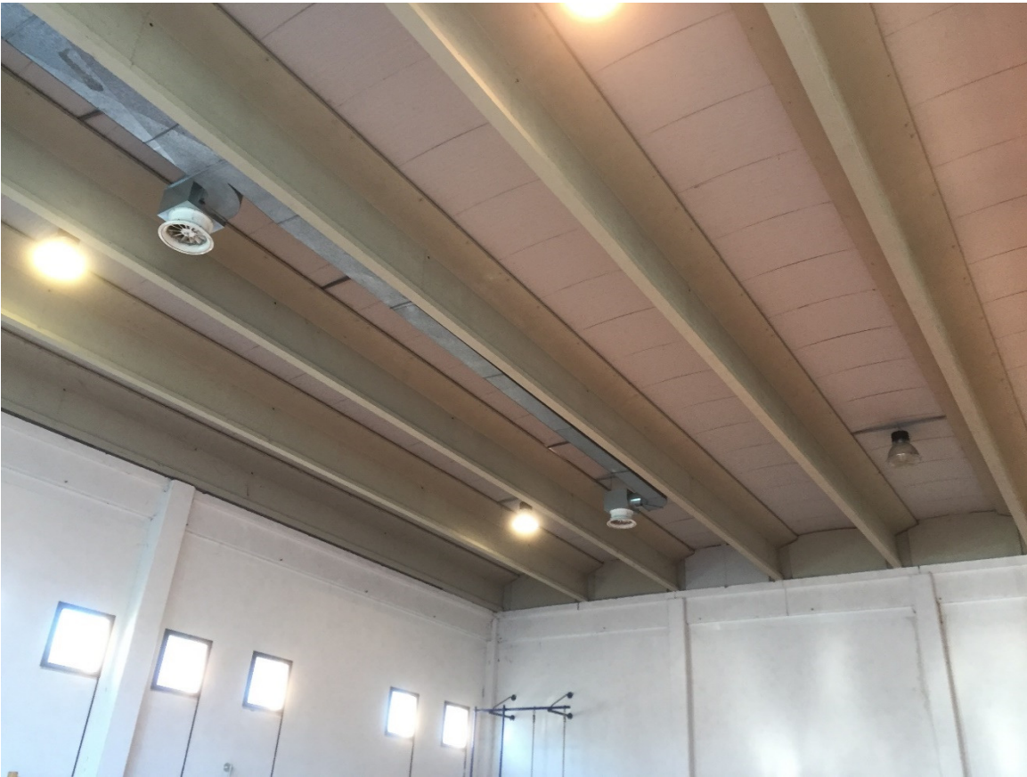
canali di mandata e bocchette di distribuzione dell'aria calda e vista delle travi a Y con voltine prefabbricate
