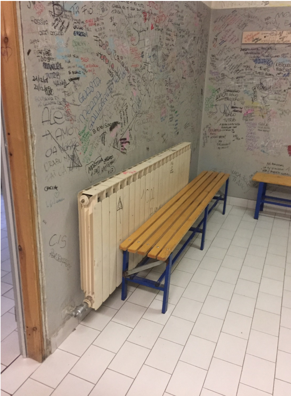
Attuale situazione degli spogliatoi degli studenti
